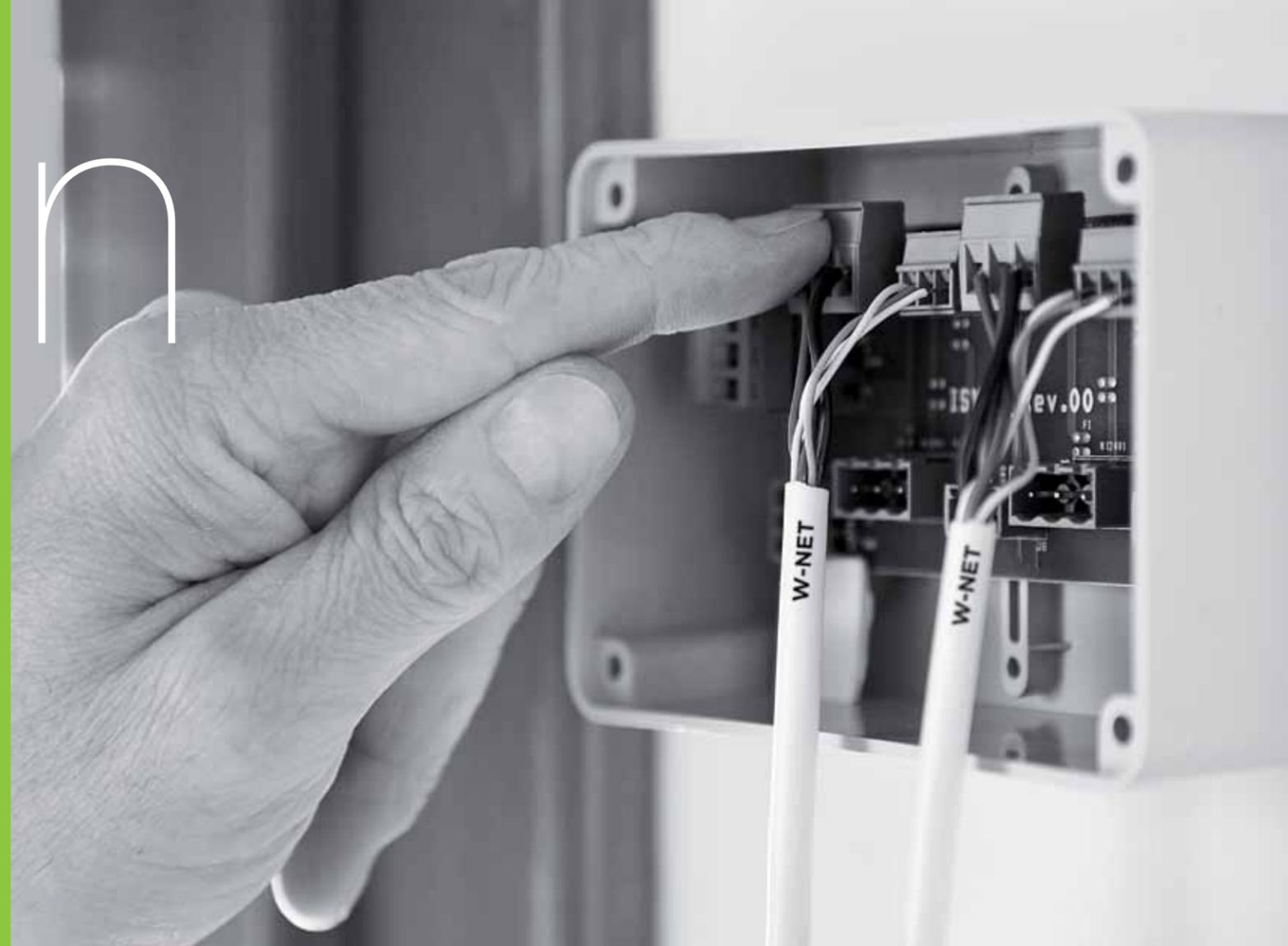
L'attivazione dell'impianto elettrico di tutto il sistema di automazione è resa estremamente facile grazie all'utilizzo di scatole di collegamento con connettori maschi e femmine già predisposti con la polarità corretta. Ogni operazione è illustrata da disegni tecnici chiari ed esaurienti che guidano ad un semplice, rapido e corretto collegamento con l'impianto generale e ad un'altrettanto semplice e pronta installazione attraverso un sistema di dime di fissaggio ed attacchi rapidi.
